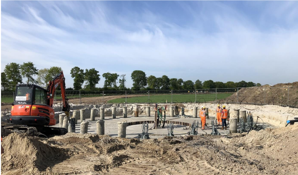
Foto: het koppensnellen van de heipalen van één van de fundaties.
